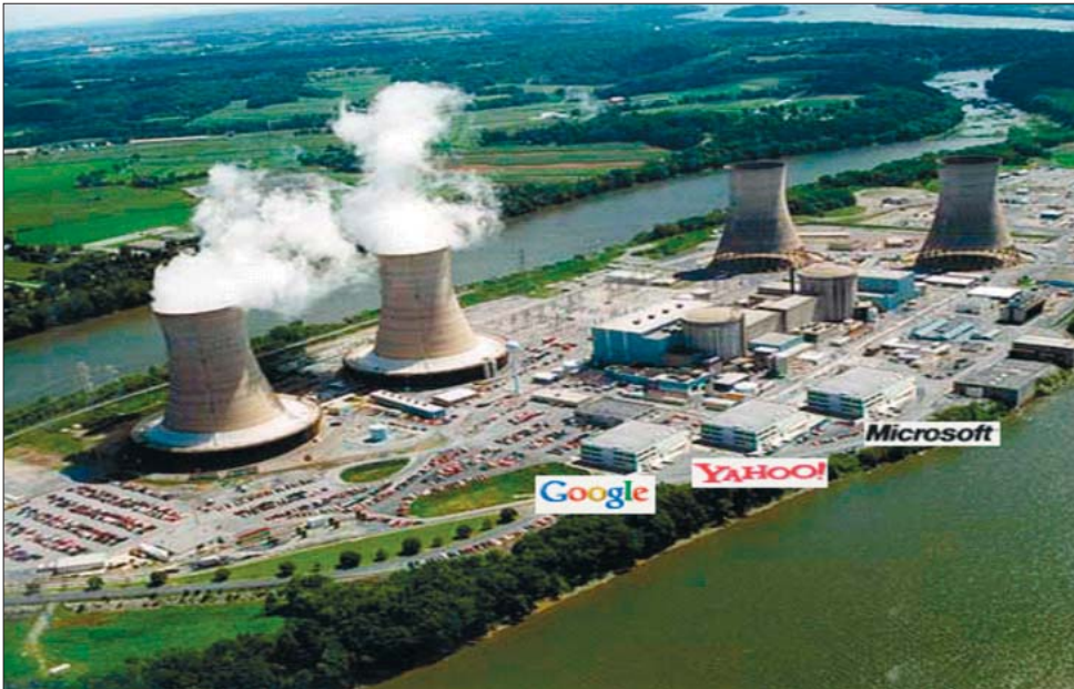
Bild 4. Die Serverfarmen von Google, Yahoo und Microsoft wurden wegen des extrem hohen Energiebedarfs direkt neben einem Kraftwerk erbaut. Sollte Microsoft Yahoo doch noch übernehmen, wäre ein Zusammenführen der Infrastruktur sehr einfach.
